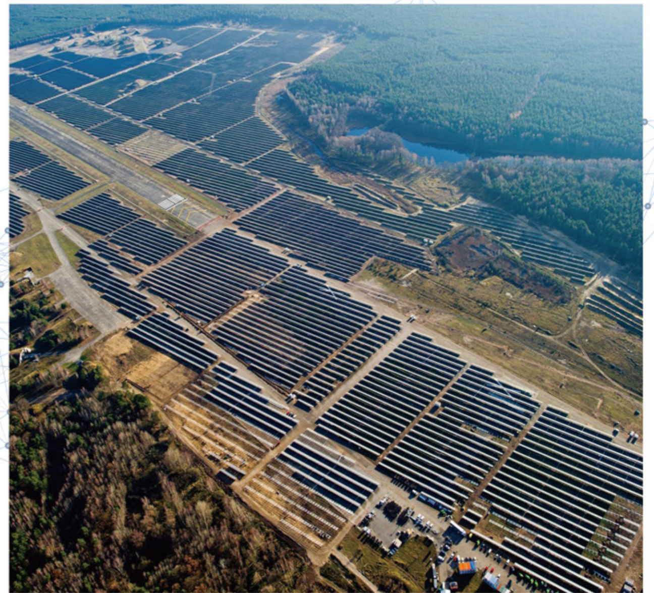
Potosi Solar PV Plant, Mexico 300MW 墨西哥波多西300MW光伏电站项目
